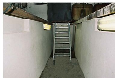
Escalier de sécurité gavanisé
